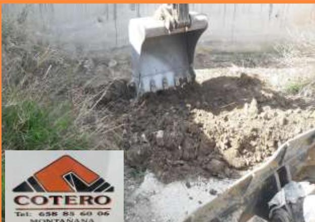
1) Para la correcta instalación del **AUTOELECTRODO-COMEX** haremos una excavación de las siguientes dimensiones: 1m. X1m. X1 m.
